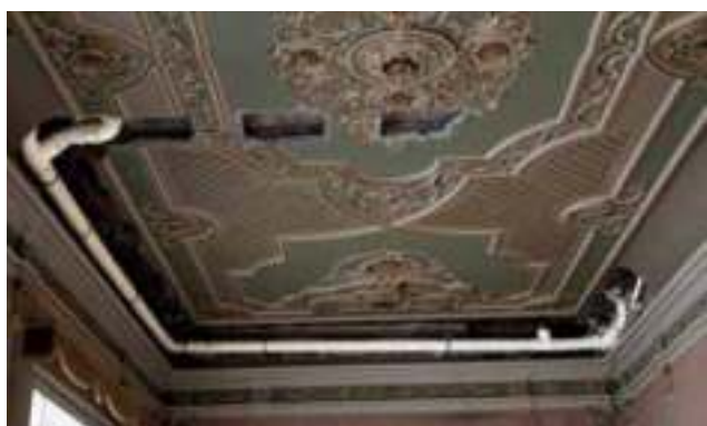
Rehabilitación de Palacete en Plaza Manises, Valencia
