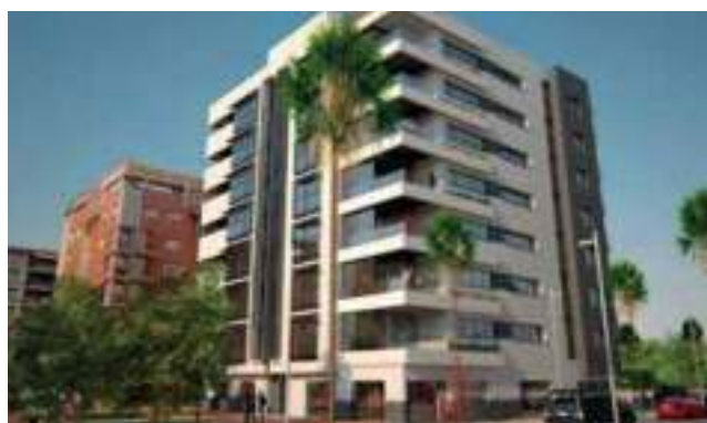
Edificio Aladas, Murcia
